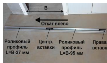
Сборка верхней направляющей
